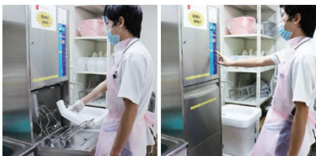
限られたスペースに収まり、湿気がこもらないことで、洗浄から乾燥までの工程をスムーズに行えることなどが、洗浄機の選定のポイントとなった。洗浄から乾燥までの工程を一括して行う洗浄機を導入し、汚物室特有のにおいを抑えられるようになったため、洗浄スペースを「汚物室」から「衛生室」に改称。イメージも改善された。
